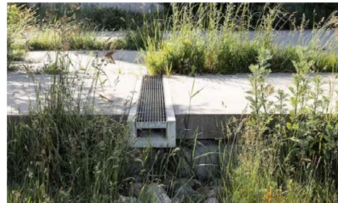
Zichtbare afvoer via goten geïntegreerd in het grid
