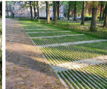
Gedeeltelijke open bestrating zorgt voor infiltratie van hemelwater en voorkomt overlast bij stortbuien.
