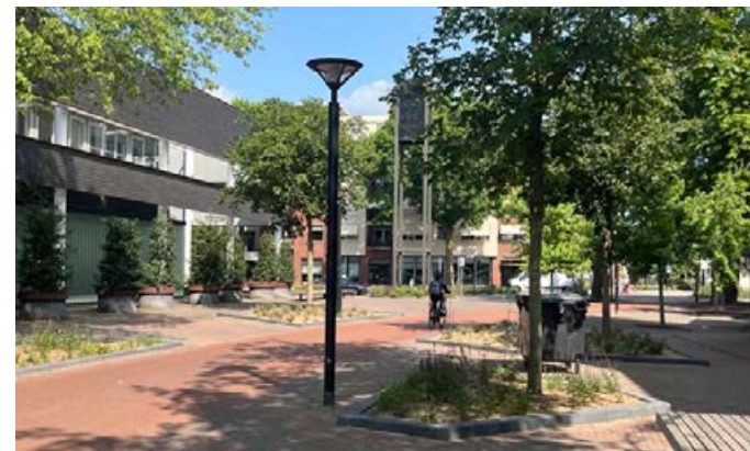
De basisverlichting bestaat uit 'standaard' paaltoparmaturen
