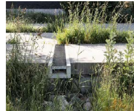
Zichtbare afvoer via goten geïntegreerd in het grid
