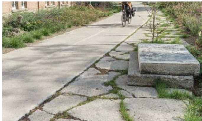
Hergebruik van betonplaten met groen ertussen als verhardingsmateriaal binnen het gebied
