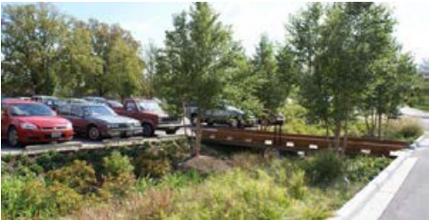
Regentuinen binnen het straatprofiel voor opvang van water en infiltratie.
