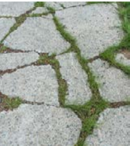
Gebroken betonplaten uit het gebied dienen als halfverharde zones
