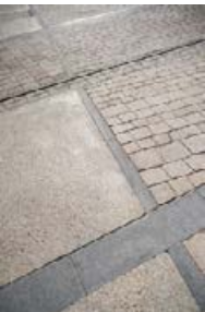
Gridstructuur van trottoirbanden en/of afwateringsgoten met (hergebruikte) bestrating
