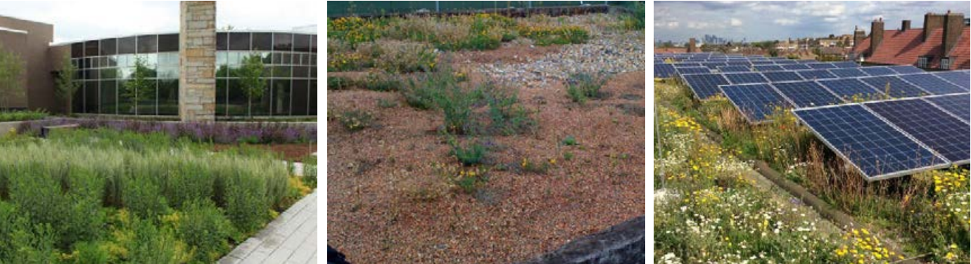
Waterretentiedak Bruin/grinddak Natuurdak gecombineerd met zonnepanelen
